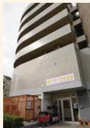
駅の目の前のビルの1階に設置
