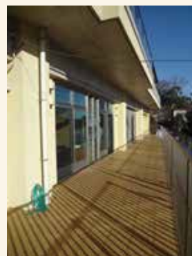
二重フェンスのベランダ。手前側には介護施設へ抜けるドアがある
