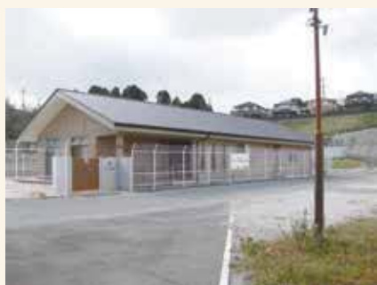
駐車場の一角を活用した 1階建ての建物
